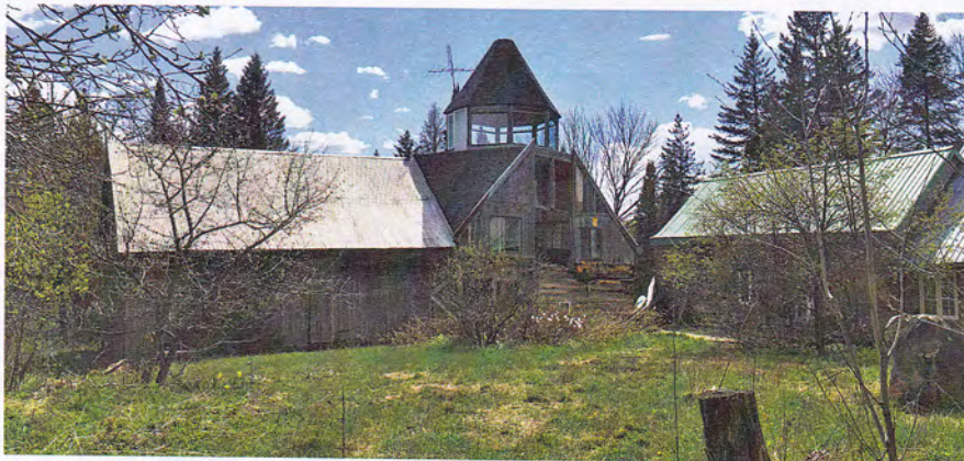
Figure 9. Ensemble de bâtiments de ferme ayant appartenu à Friedhelm Heinrich Lach. Site inoccupé depuis 2019. Photo: Ginette Mayer
